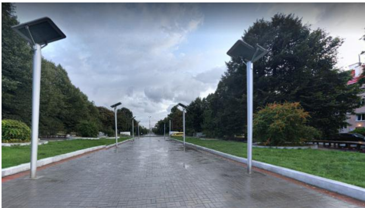
Рис.3 - Солнечные батареи для освещения аллеи в Калининграде
