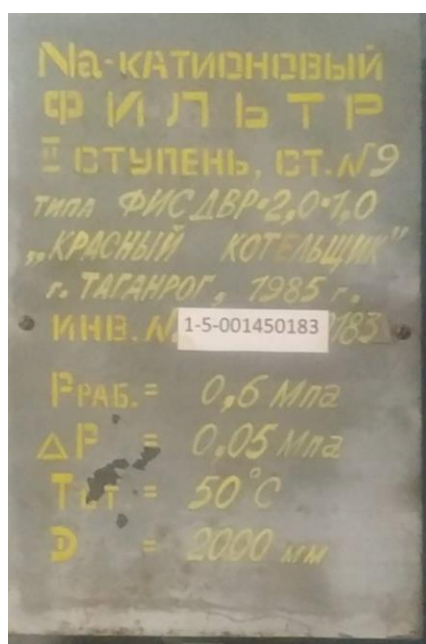
Рисунок 46. Общий вид Na-катионитового фильтра и информационной таблички
