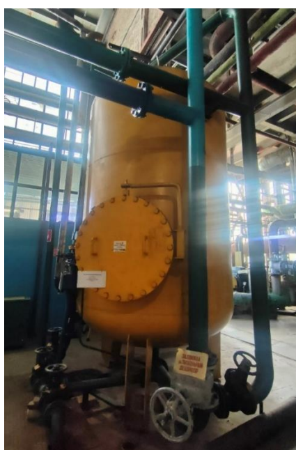
Рисунок 46. Общий вид Na-катионитового фильтра и информационной таблички
