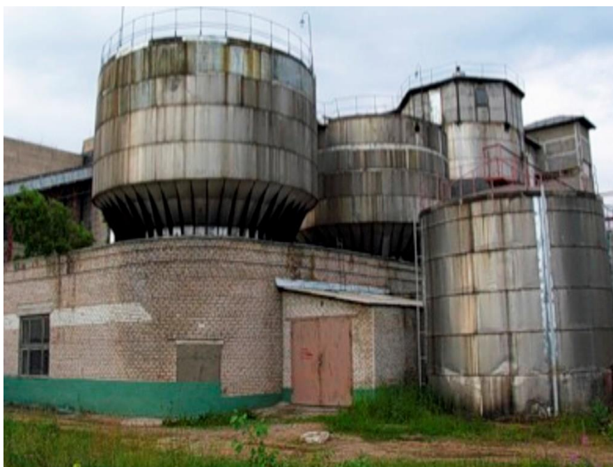
Рисунок 27. Общий вид коагуляционной установки
