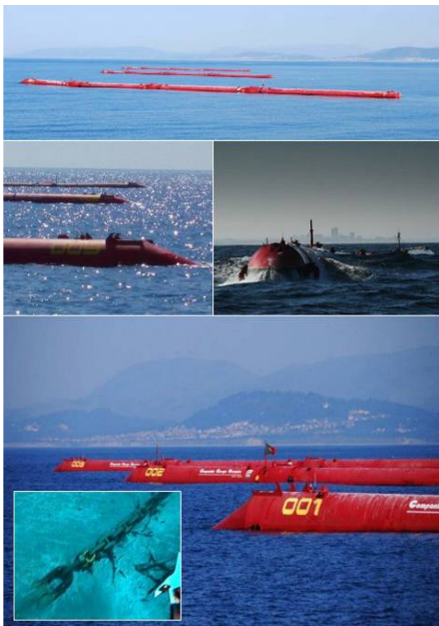
Рисунок 2.2 – Внешний вид волновой электростанции Pelamis P-750
