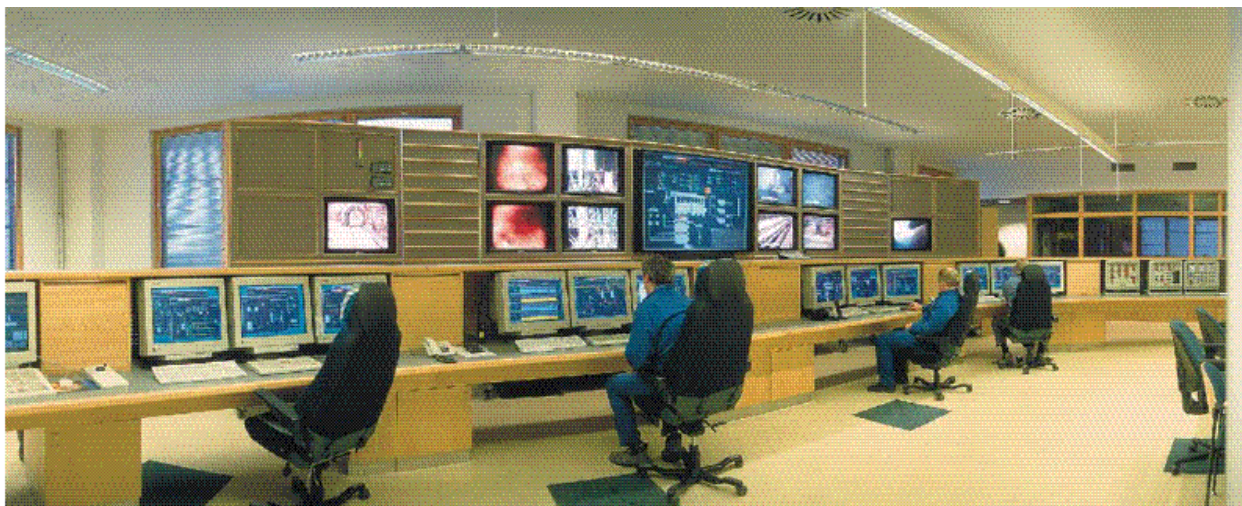
Рис.73. Помещение оператора - технолога
