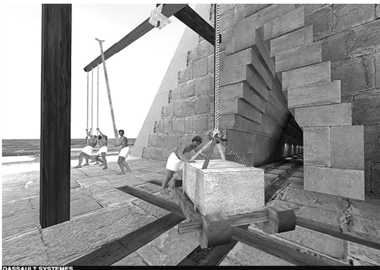
Рис. 5. Применение рычагов при строительстве египетских пирамид
