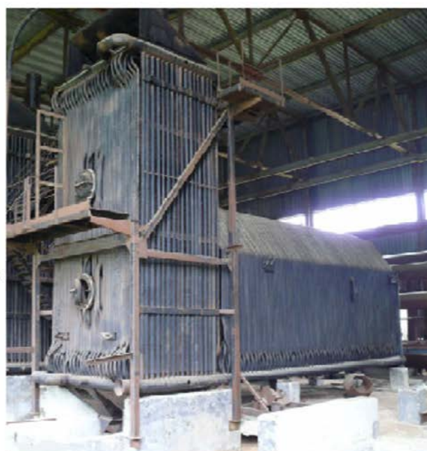
Рисунок 5.18 – Водогрейные котлы КВ-ГМ-10, -20, -30:
