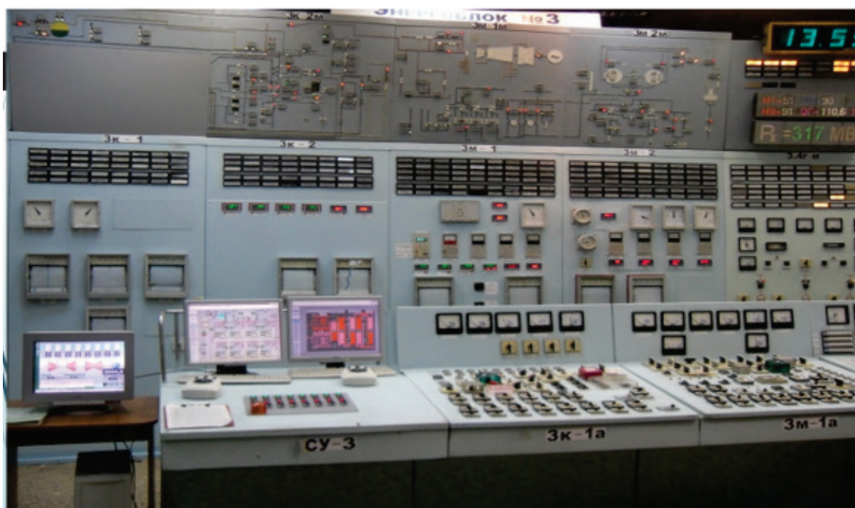
Рис. 1.1. Размещение органов управления и системы отображения информации (мнемосхем) на пульте управления энергоблока
