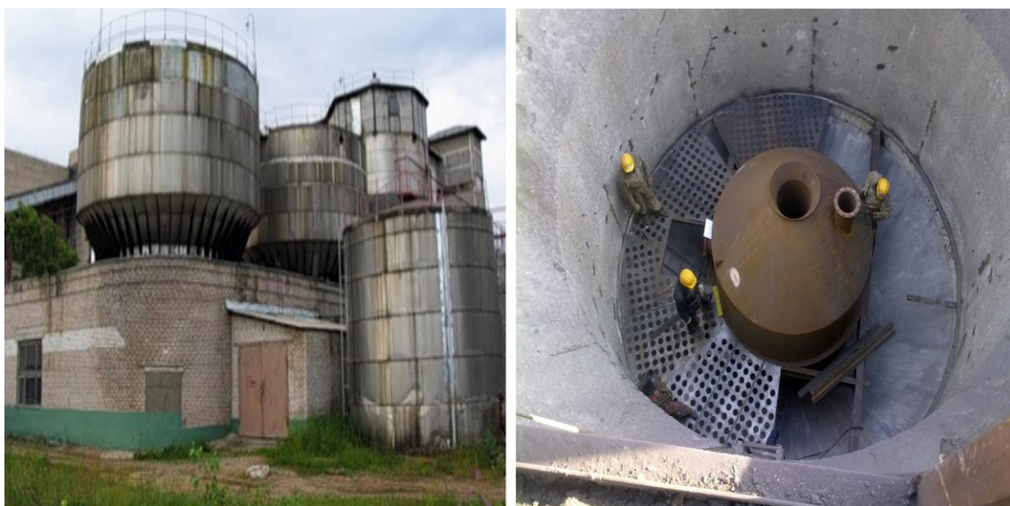
Рисунок 30. Общий вид коагуляционной установки
