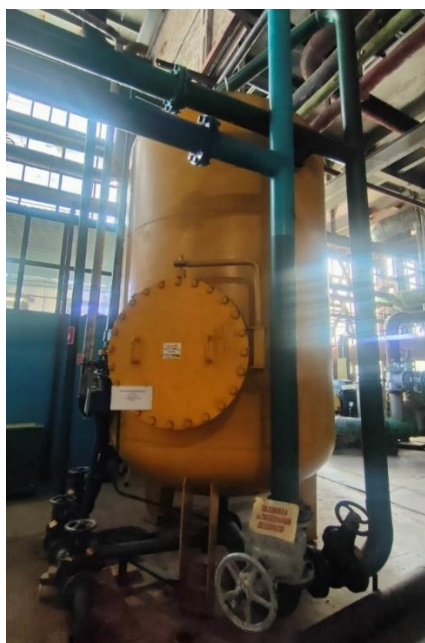
Рисунок 46. Общий вид Na-катионитового фильтра и информационной таблички
