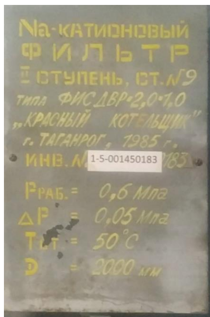
Рисунок 46. Общий вид Na-катионитового фильтра и информационной таблички
