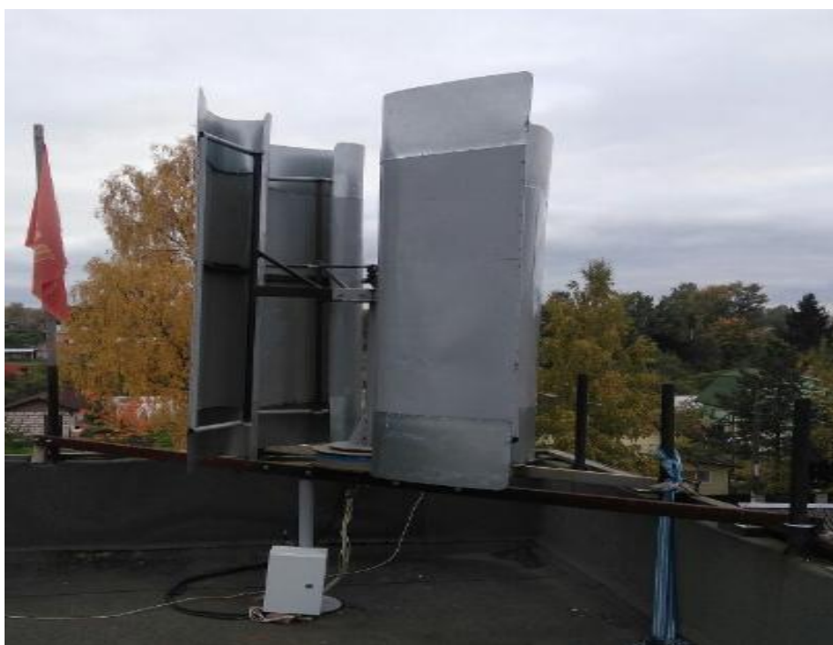
Рис.2. Ветроэнергетическая установка вертикального типа с автодинамической ориентацией лопастей на ветер
