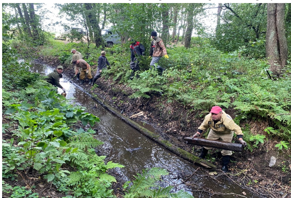
Рисунок 2 – Ручная расчистка мелиоративной канавы
