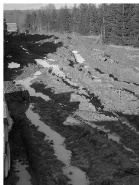
Рисунок 2 – Образование колеи на погрузочном пункте
