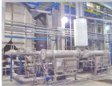
Рис. 6. Напорные флотаторы MegacellTM MCV-60.4 со вспомогательным оборудованием
