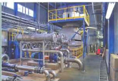
Рис. 5. Флотатор для сгущения шлама песчаных флотофильтров доочистки стоков.
